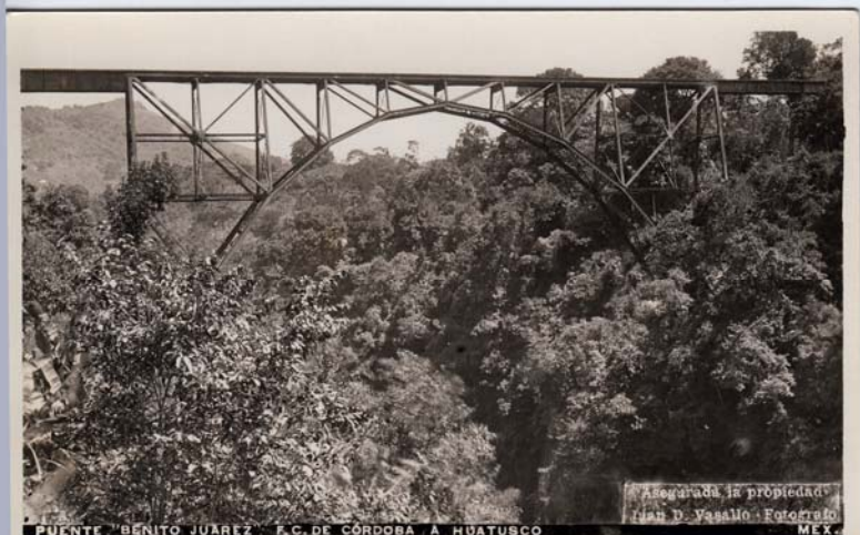
PUENTE BENITO JUÁREZ F.C. DE CORDOBA A HUATUSCO
