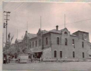
Estación de San Lázaro México del ferrocarril central Interoceánico construida por Don Delfino Sánchez Ycano de Don Benito Juárez, 1876.
